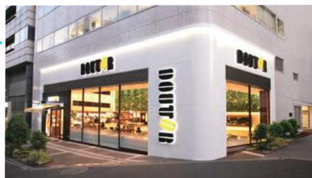
店舗のサイン看板や店内照明にLEDを導入
